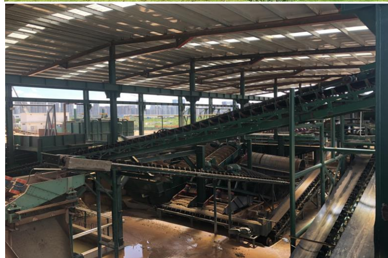
临时装船点现场配建泥砂分离设施
