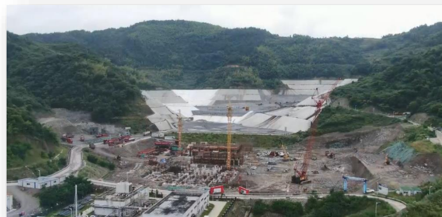
新昌垃圾焚烧厂
